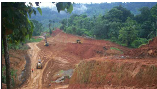
Foto 1: Construção e preparação para pavimentação de rodovia da obra para Changuinola I em 2005
